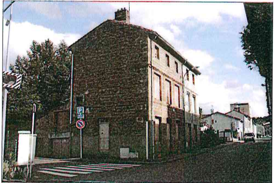
■ La commune est désormais propriétaire de tout ce bâtiment (deux maisons accolées) à l'angle de la rue de Curnieu et de la rue du Jeu-de-Boules. L'ensemble sera détruit pour réaliser un nouveau boulevard urbain en direction de l'avenue de l'Industrie. Photo Pierre THOILLIÈRE
