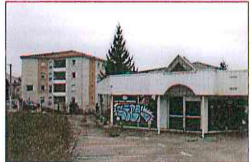
■ L'ancien garage Renault fait partie du programme des démolitions prévues en 2017. Photo Pierre THIOLIERE
