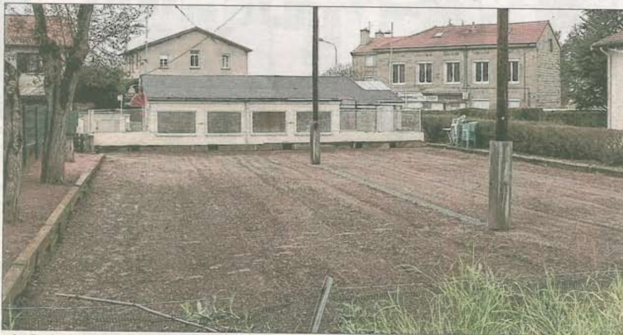
■ La Boule de l'Hippodrome va prochainement cesser ses activités et le terrain municipal servira à élargir la voie d'accès au futur espace Beaunier. Photo Pierre THOILLIERE
