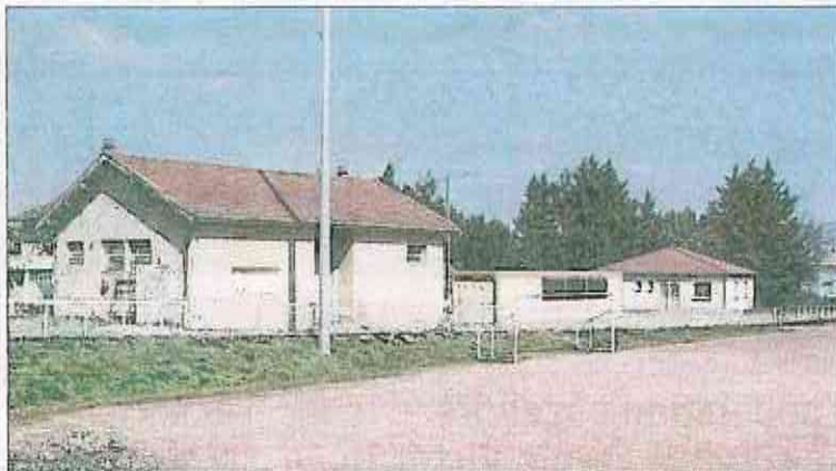
500 000 euros ont été affectés à l'espace Beaunier. En partie pour financer des démolitions, comme les vestiaires et l'ancien local des scouts au stade Paul-Bert. Photo Le Progrès/Photo Pierre THIOLIERE
