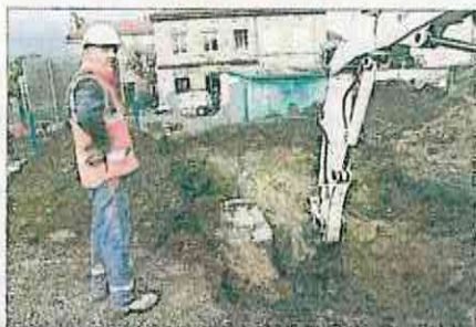
Le chantier a commencé par la pose d'un réseau d'eau pluviale. Photo Progrès/Pierre THIOLIERE
