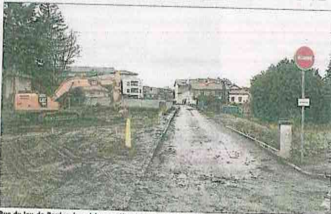
Rue du Jeu-de-Boules, la voirie sera élargie. Les travaux, en cours, dureront jusqu'à fin avril.
