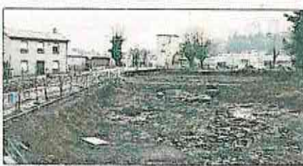
Pour aménager la future voirie, il importe de trouver le dur dans le sous-sol. Photo Progrès/Pierre THIOLIERE
