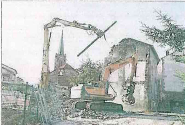
L'aménagement de l'espace Beaunier a commencé par une phase d'acquisitions puis de démolitions. Photo d'archives Progrès Pierre THIOLIERE
