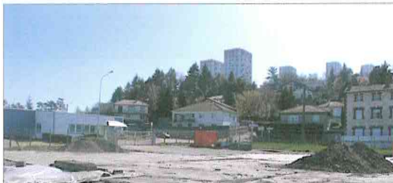
Le terrain de l'ex-garage Renault sera finalement dépollué par Epora puis racheté par la commune avec comme objectif la construction d'un immeuble. Photo Progrès/Pierre THIOLIERE
