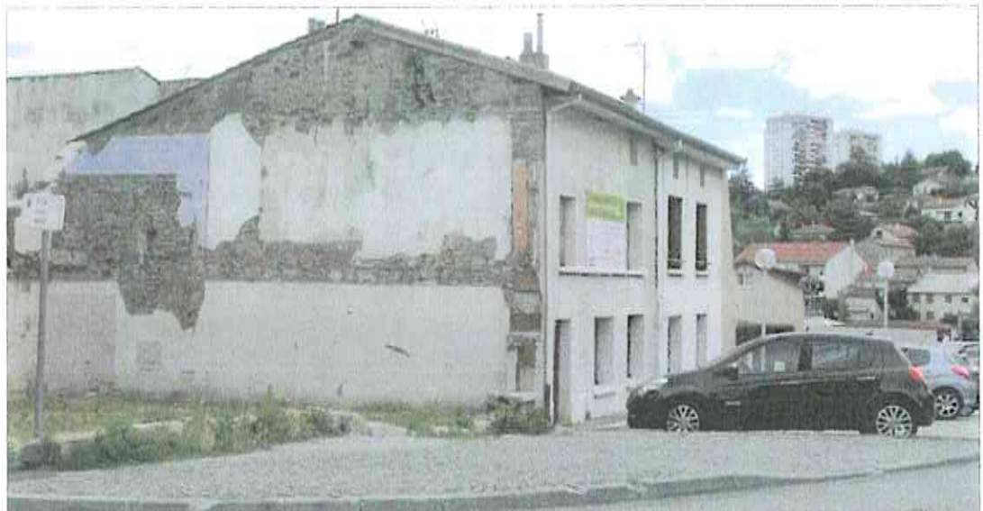
Les dernières maisons au bout de la place Gambetta sont désormais dans le périmètre communales et seront démolies après désamiantage. Photo Pragers/Pierre THOLIERE
